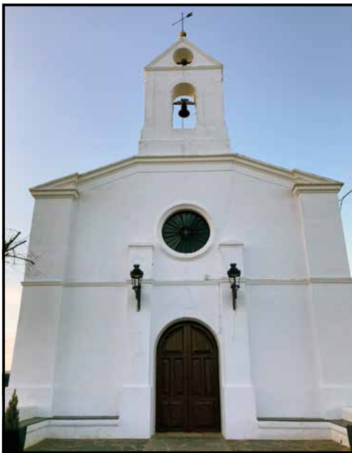
Fig. 267. Fachada de la Ermita del Corazón de Jesús. Fuente: Agradecimiento por las imágenes al arquitecto D. Víctor Flores Ventura.
