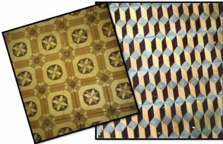
Fig. 63 a 65. Columnas de hierro de forja [en la actualidad pintadas de blanco] y aspecto de la escalera que da acceso a los palcos, donde se encuentra el lucernario. Detalles de baldosín hidráulico encontrado en la segunda planta. Asimismo en la planta baja se realizó con baldosín hidráulico liso en colores beige, marrón y negro realizando un dibujo geométrico gigantesco que ocupa todo el salón a modo de alfombra. Fuente: imágenes de la autora.
