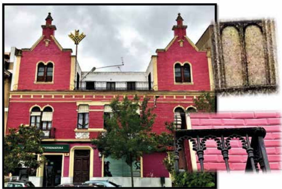
Fig. 208 y 209. Extinto Hotel Cabañas en Zafra. Detalle de la reja, formando arcos poli lobulados, idénticos a los que encontramos en la casa del Marqués de Solanda. Boceto.
