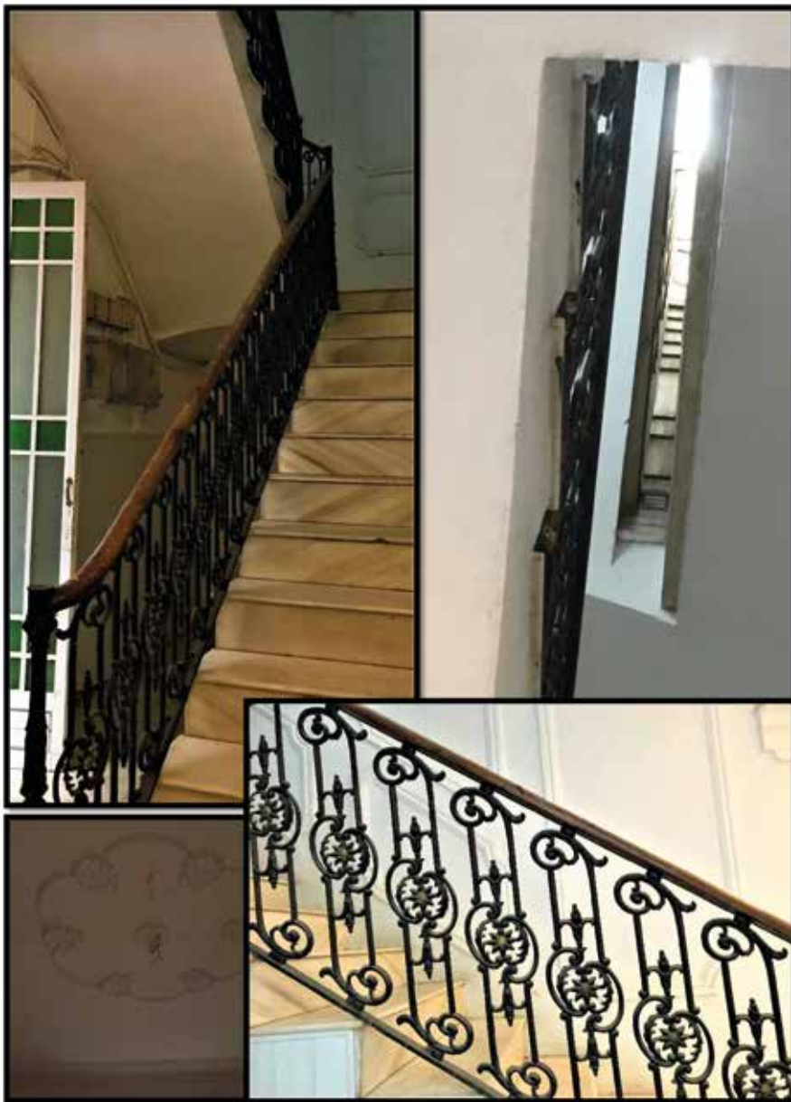
Fig. 232 a 235. Escalera de forja, adornos del techo y lucernario en la parte superior del edificio. Fuente: Imágenes de elaboración propia.
