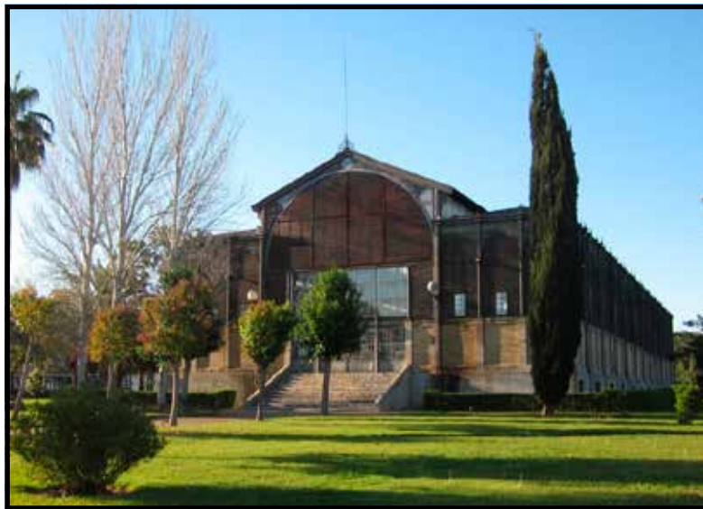
Fig. 162. El Edificio Metálico se trasladó al campus universitario en 1997 bajo la dirección del arquitecto Eduardo Escudero y ha sido respetuosamente rehabilitado por el arquitecto Francisco Hipólito Ojalvo en 2018.
