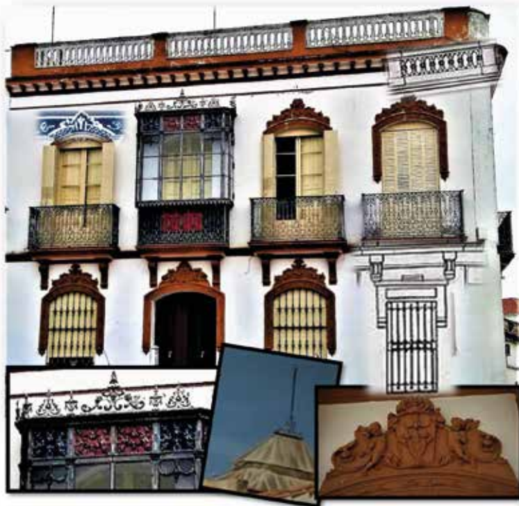
Fig. 618 a 620. Sólida vivienda de la localidad, tal vez perteneciente a alguno de los mayores contribuyentes citados anteriormente. Detalles del mirador de hierro, lucernario y angelitos, reiterados en sus abundantes trabajos. Fuente: Imagen de D a . M a . José Parreño Medel.
