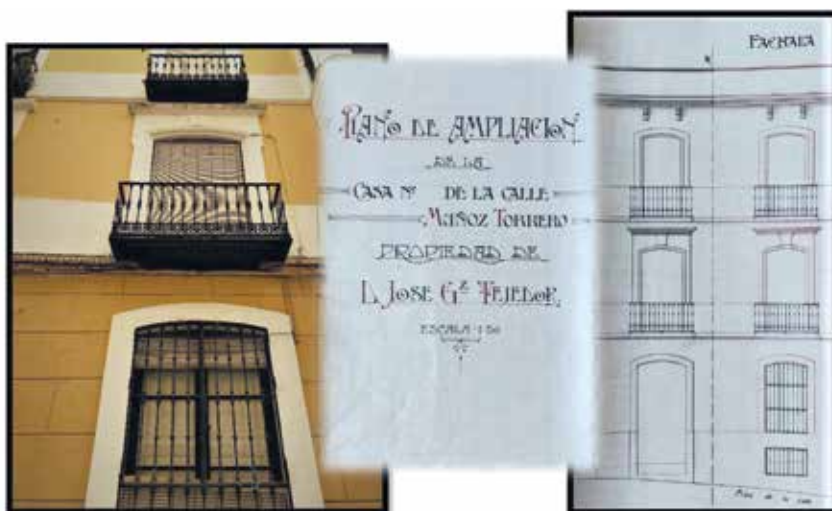
Fig. 893 a 895. La nueva estructura adosada respetó el aspecto inicial del edificio, exceptuando los miradores. [Podemos observar en el plano la raya vertical que traza entre lo construido y lo pendiente de construcción]. Fuente: Sección vías y obras año 1922. AHMB.
