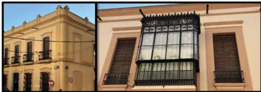
Fig. 637 y 638. Viviendas en la calle Estacada, 2 y 6, que presentan remarcado en mármol o mirador similar al del Conservatorio de Música en Badajoz. Fuente: Imágenes de la autora.
