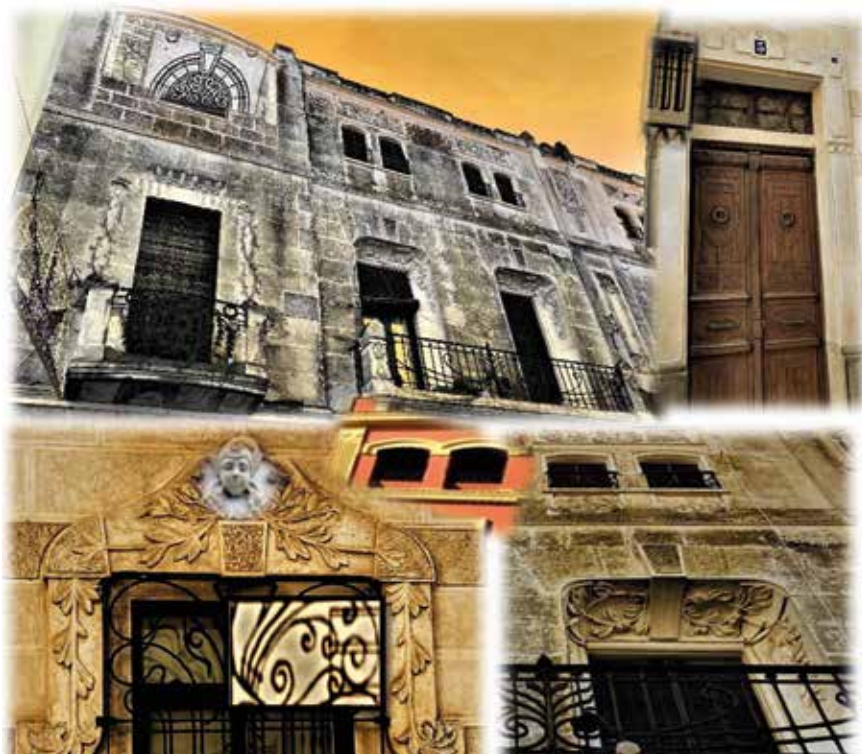
Fig. 736 a 738. Detalle de los rostros en la fachada, decoración vegetal, ventanas geminadas (idénticas a las del conservatorio de música de Badajoz), o remarcado de puerta labrada en mármol, utilizadas por el arquitecto en otras muchas de sus viviendas modernistas, por ej. de la familia Navarrete en Badajoz. Bocetos superpuestos.
