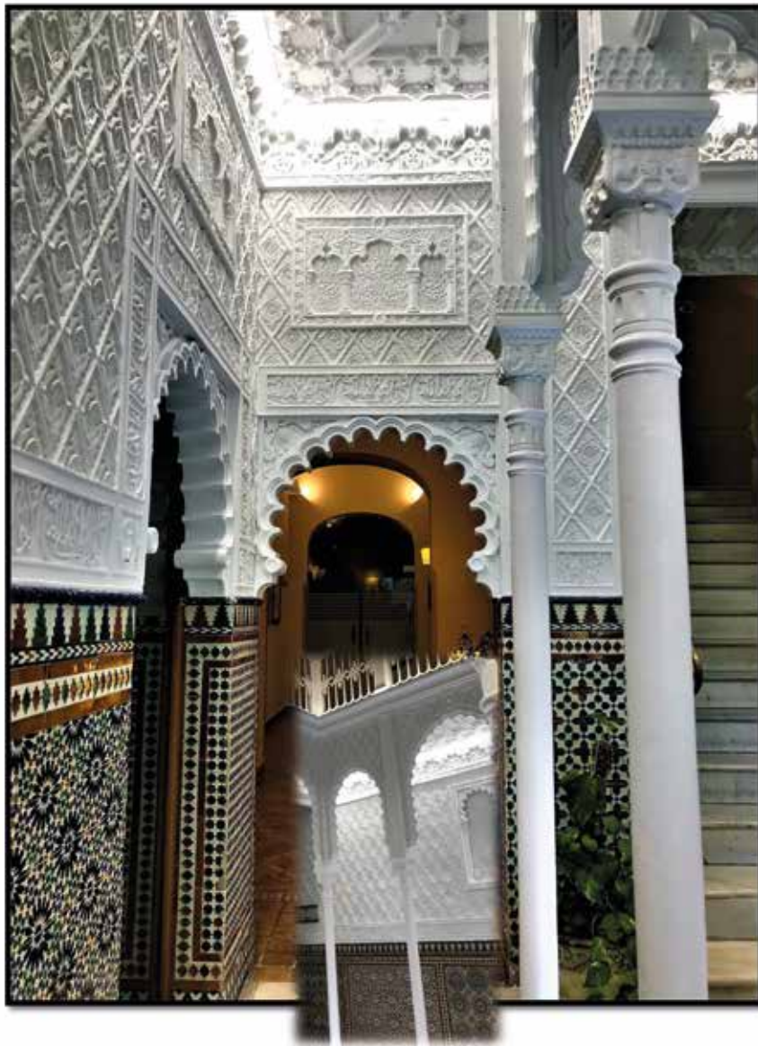
Fig. 720. Diferentes modelos de azulejos en cada tramo del friso que rodea el patio. Columnas de hierro de forja pintadas en color blanco. Fuente: fotografías de elaboración propia. /Estimamos que encontrándose en Zafra los maestros alarifes de marruecos que recomendó traer Ventura Vaca al Marqués de Solanda, se aprovechase su estancia en la provincia de Badajoz para la construcción de este patio y el que se encuentra en Fregenal.
