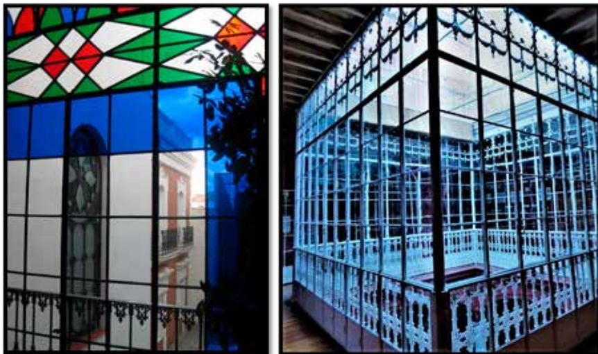
Fig. 128 y 129. Patios acristalados en la hospedería "El Mirador de Llerena" o en la Casa-Palacio "Conde de la Corte" (Zafra). Fuente: Elaboración propia.
