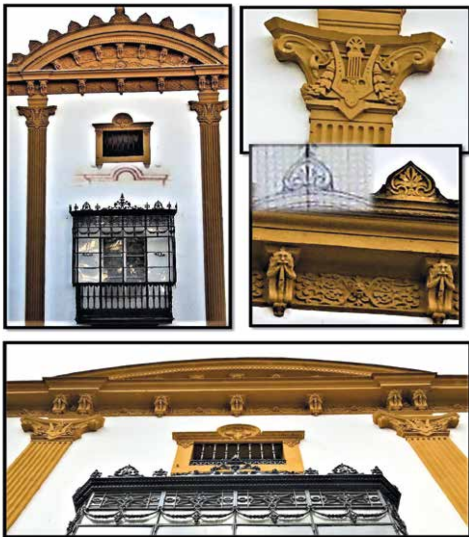
Fig. 837 a 840. Detalle del "frontón sin vuelta" (en la parte superior de la fachada) de la casa-palacio del Marqués de Solanda en Zafrá. Este recurso arquitectónico, también podemos observarlo en otras obras de Ventura Vaca como en la fachada de la Diputación Provincial, o el colegio Trajano de Mérida. Podemos citar otra construcción realizada en 1905, la famosa casa-museo modernista de Novelda (Alicante) del arquitecto Pedro Cerdán que emplea también este mismo recurso. /Fragmentos de la fachada: el capitel corintio presenta arpas y la cornisa, pequeñas caras de aspecto teatral alternadas con cabezas de león en el friso. Por otra parte, podemos observar sus típicos miradores de hierro y cristal. La fachada es de estilo ecléctico con tintes de influencia italiana. Fuente: Fotografías de elaboración propia.
