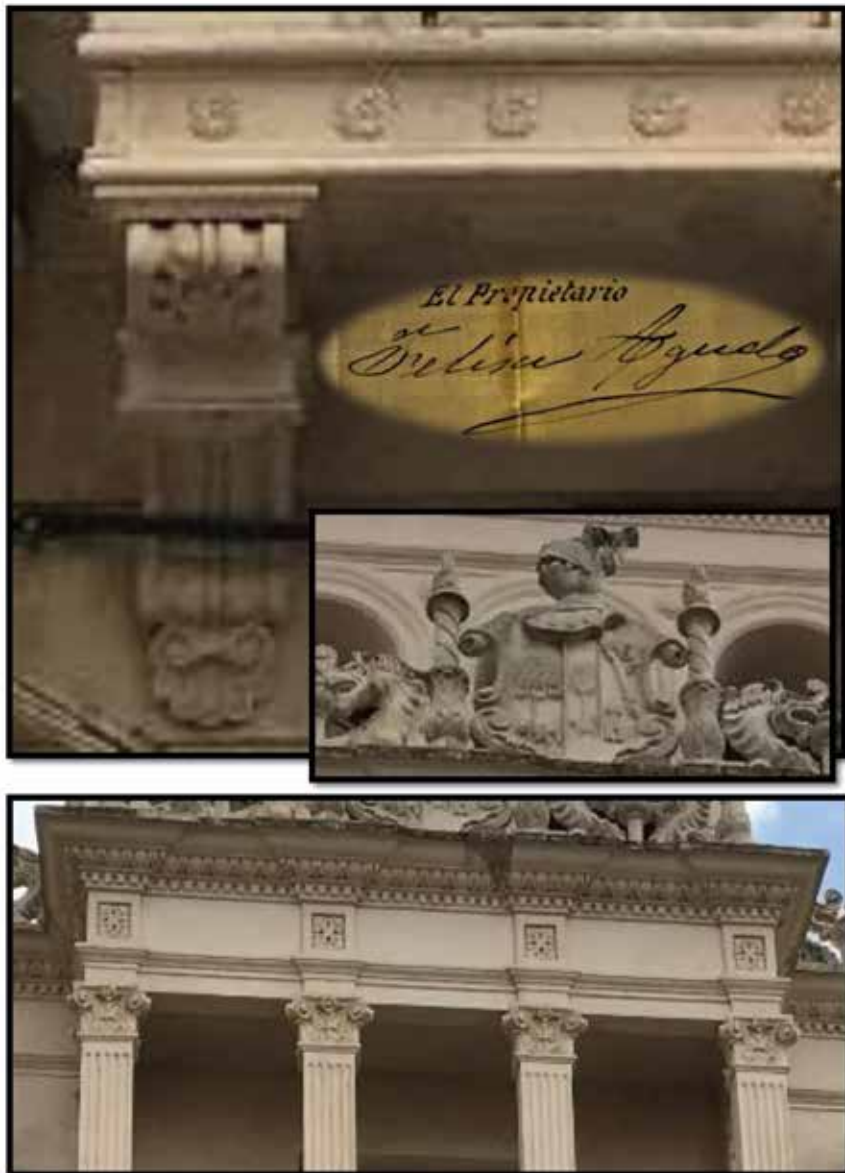
Fig. 250 a 253. Detalles de la fachada. Conchas, ornatos cuadrados, columnas corintias estriadas o escudo del linaje que une a ambas familias, los dragones que forman parte de las armas de la familia Pérez Caballero coronan el edificio. Fotografías de la autora.
