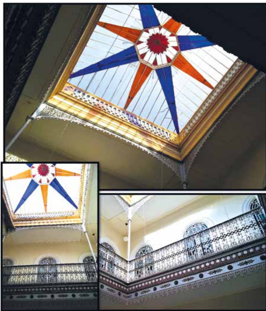
Fig. 615 a 617. Lucernario y patio con arcos de fundición. Las puertas con vidrieras es evidente que han sufrido una reforma, debían ser de forja en su color. /Al fallecimiento del propietario, el palacete pasó a su hija Doña Araceli Spínola de Llera. Posteriormente en el año 1986 fue vendido al municipio para la instalación de la Casa Consistorial. Fuente: Imágenes de Doña María José Parreño Medel
