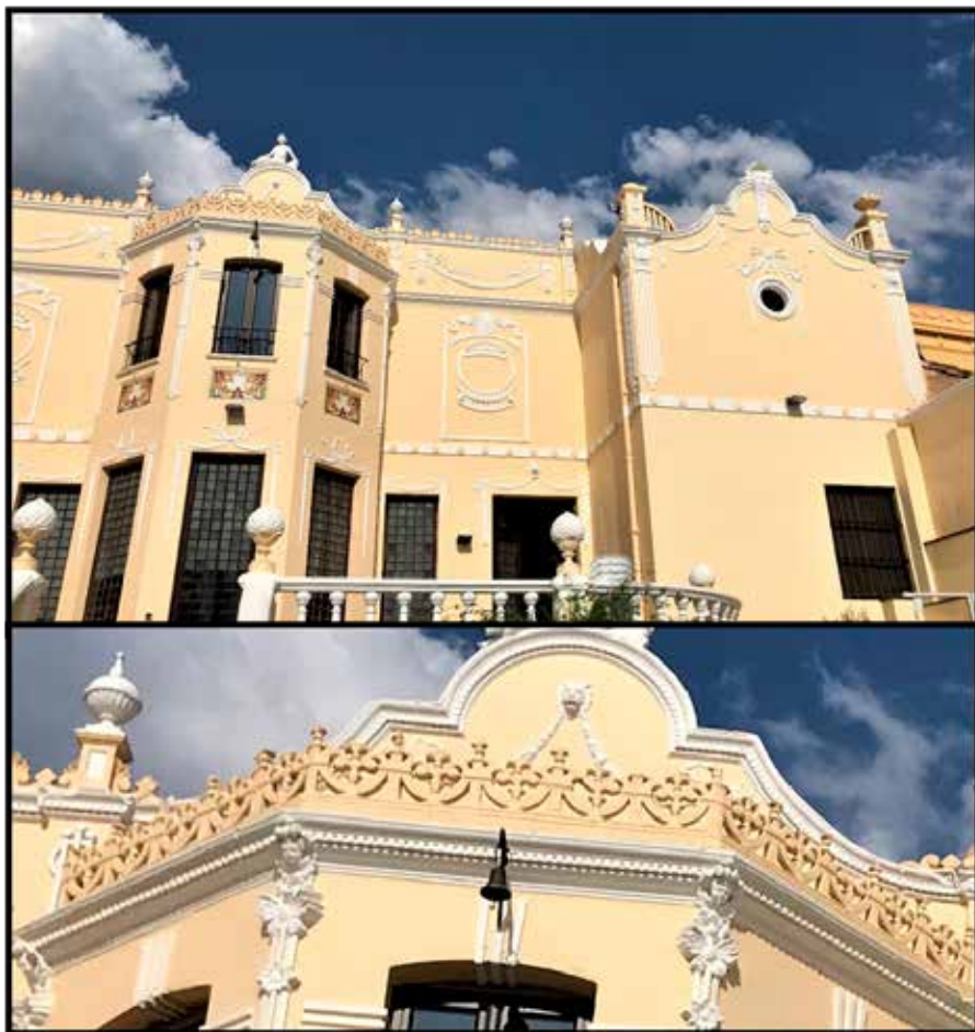
Fig. 507 y 508. Detalles de las cabezas de león y angelitos en la fachada del jardín interior, comunes en numerosos edificios del arquitecto.
