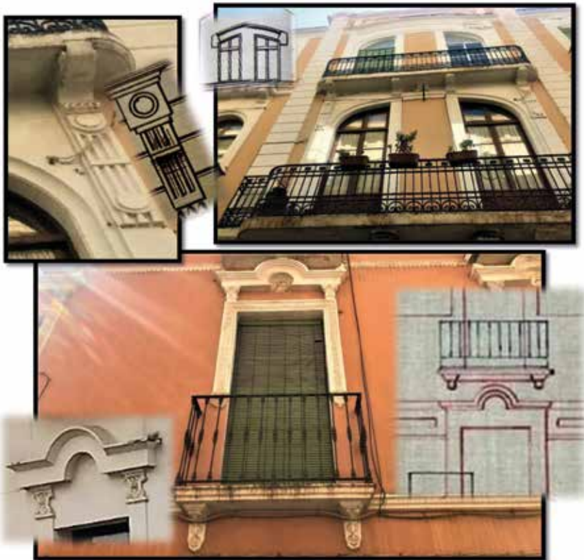
Fig. 939 y 941. Edificaciones en Arco-Agüero, en la imagen superior observamos la coincidencia del balcón partido con el de uno de los palacetes de Barcarrota, y los remates con forma de cuerdas musicales bajo el balcón. En la inferior las imágenes esculpidas en yeso en la parte superior central con frontones semicirculares, también similares a los de la sede del Colegio de Arquitectos de Badajoz propiedad de la familia López-Lago.
