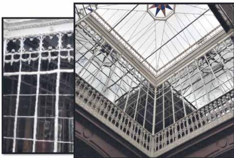
Fig. 852 y 853. Patio acristalado de hierro forjado, con adornos típicos del arquitecto en los miradores de hierro. Fuente: elaboración propia.
