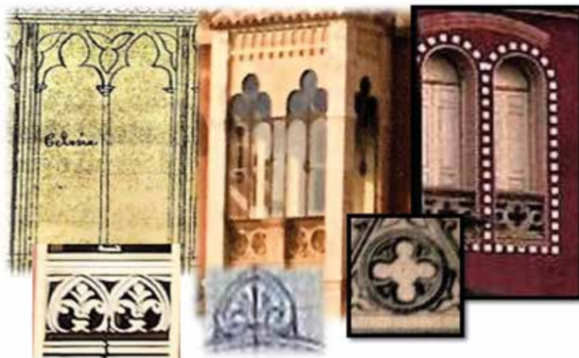
Fig. 883 a 892. Comparativa entre el mirador de obra, hierro y cristal en el cortijo "Casa Colorada" y boceto del arquitecto para la obra del convento de las Adoratrices que data de 1888. Comparativa de varios adornos bajo las ventanas geminadas, procedente de otros planos. Los miradores cuyos componentes son obra, hierro y cristal, se convierten en una constante en los trabajos del arquitecto. Los tejadillos serán similares a los realizados para el Casino de Granja de Torrehermosa.
