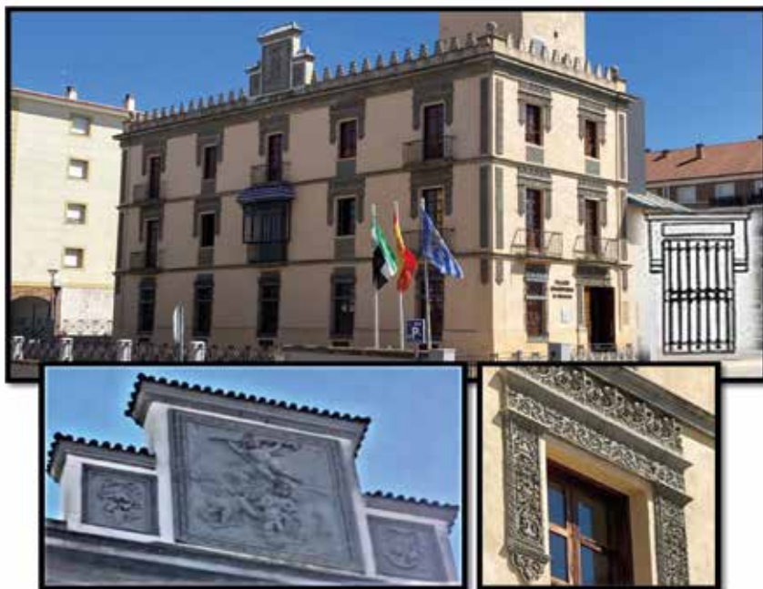
Fig. 825 a 827. “La Jabonera”. Detalles de la fachada. Fuente: Imagen de la autora.
