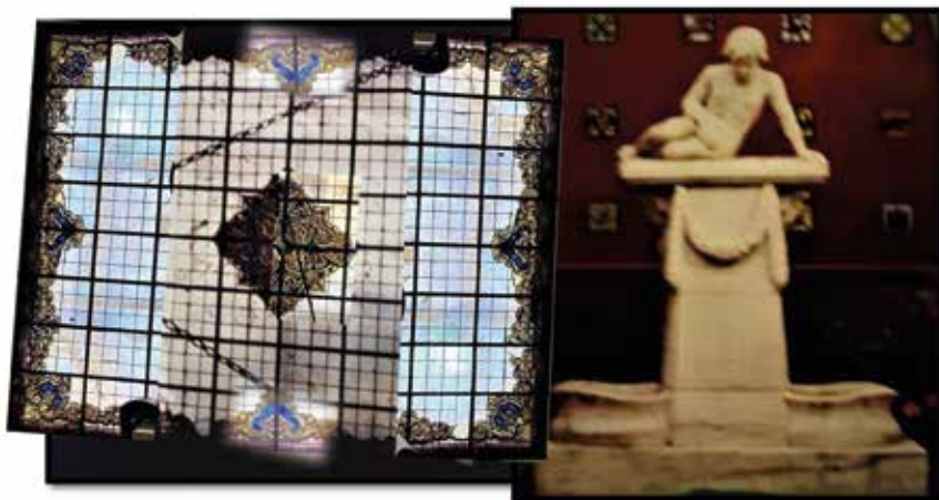
Fig. 195 y 196. Lucernario en la entrada, iluminando la escalinata. En este caso, la claraboya está propuesta en forma horizontal tal como lo diseña para la casa Álvarez o el Centro Obrero. Los techos se encuentran a gran altura. / La fuente que se encuentra en el interior del patio es de mármol y está adornada con la escultura de un niño y flores. Doña Teresa Thomas Sainz de Baranda era la mujer del empresario
