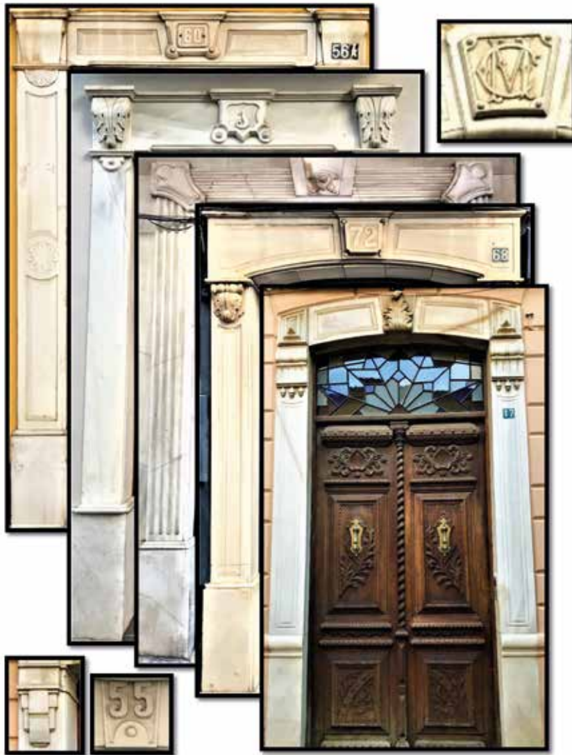
Fig. 950 a 956. Remarcado con moldura en mármol en las portadas de viviendas con más presupuesto, algunas de ellas además están acompañadas de vidrieras o rejillas para dar paso a la luz en el interior del portal. Fuente: fotografías de elaboración propia.
