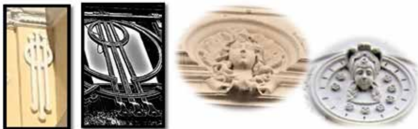
Fig. 509 a 512. Detalles musicales en la reja de la vivienda modernista en la calle Eche-garay, 6, hoy Virgen de la Soledad, de Badajoz y detalle en mampostería de caracterís-ticas similares en esta construcción. Fragmentos de la fachada principal del palacete y del colegio Trajano en Mérida, con cabeza de mujer joven.
