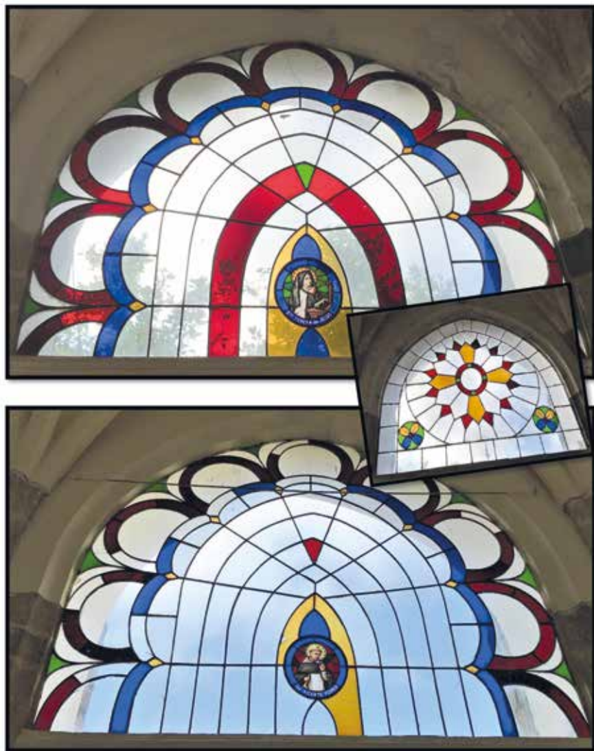
Fig. 272 a 274. Claustro de la Santa Iglesia Catedral. Vidrieras. [Con el paso del tiempo, desafortunadamente, los cristales de color se han ido sustituyendo por otros transparentes]. Fuente: fotografías de la autora.
