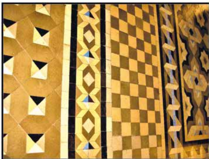
Fig. 674 a 675. Techos decorados con motivos florales y vegetales y solería de baldosín hidráulico realizando dibujos geométricos que simulan una gran alfombra.
