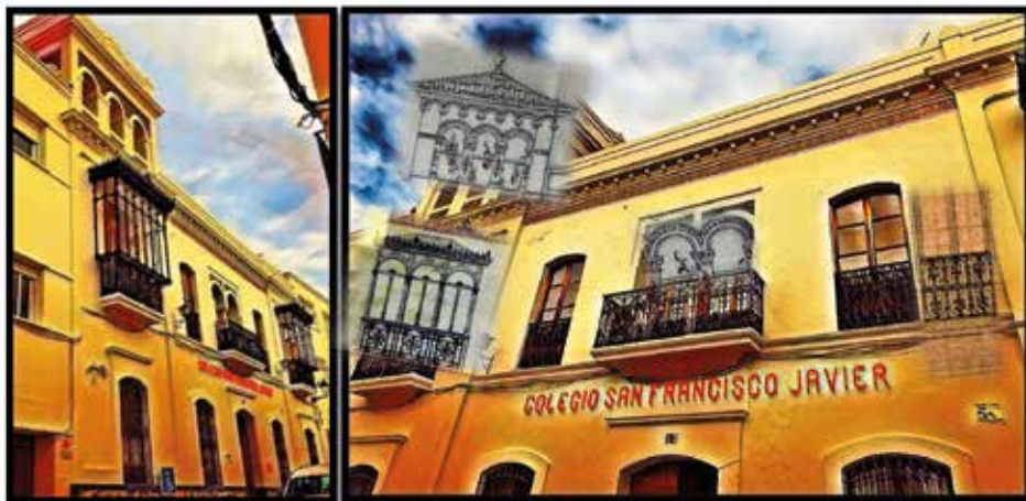
Fig. 601 a 602. Imagen de la fachada del edificio con planos del arquitecto superpuestos. Emanan en la fachada del edificio: torreón de tres arcos con azulejos sobre estos, miradores de hierro fundido, arcos geminados, rejerías, balcones retranqueados, azulejería cordobesa en zócalo interior, cornisa bajo el torreón y sobre los miradores, etc. Fuente: Planos del Archivo familiar de Francisco Vaca Morales. Imágenes de la autora.
