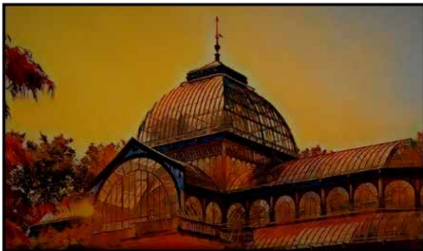
Fig. 8. Palacio de Cristal en el parque del Retiro en Madrid, realizado por el arquitecto Ricardo Velázquez Bosco. Fuente: (Fotografía de elaboración propia.)
