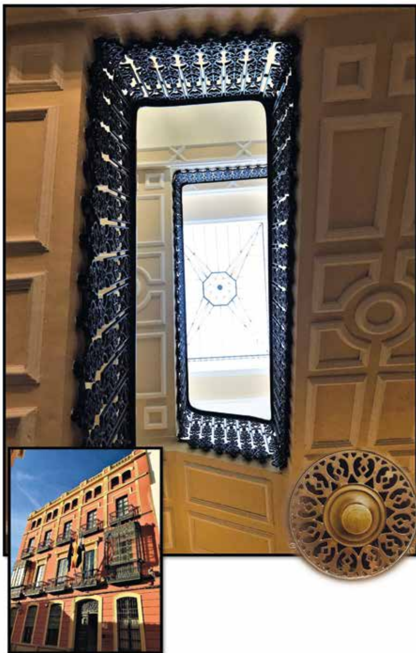
Fig. 411 a 413. Detalles del edificio: Lucernario, yeserías en techo, llamador, balaustrada.
