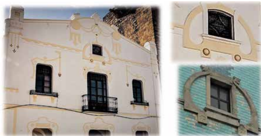
Fig. 740. Edificio de la antigua Cámara Agraria, comparativa de la ventana central y las de la casa Goitia de Zafra.
